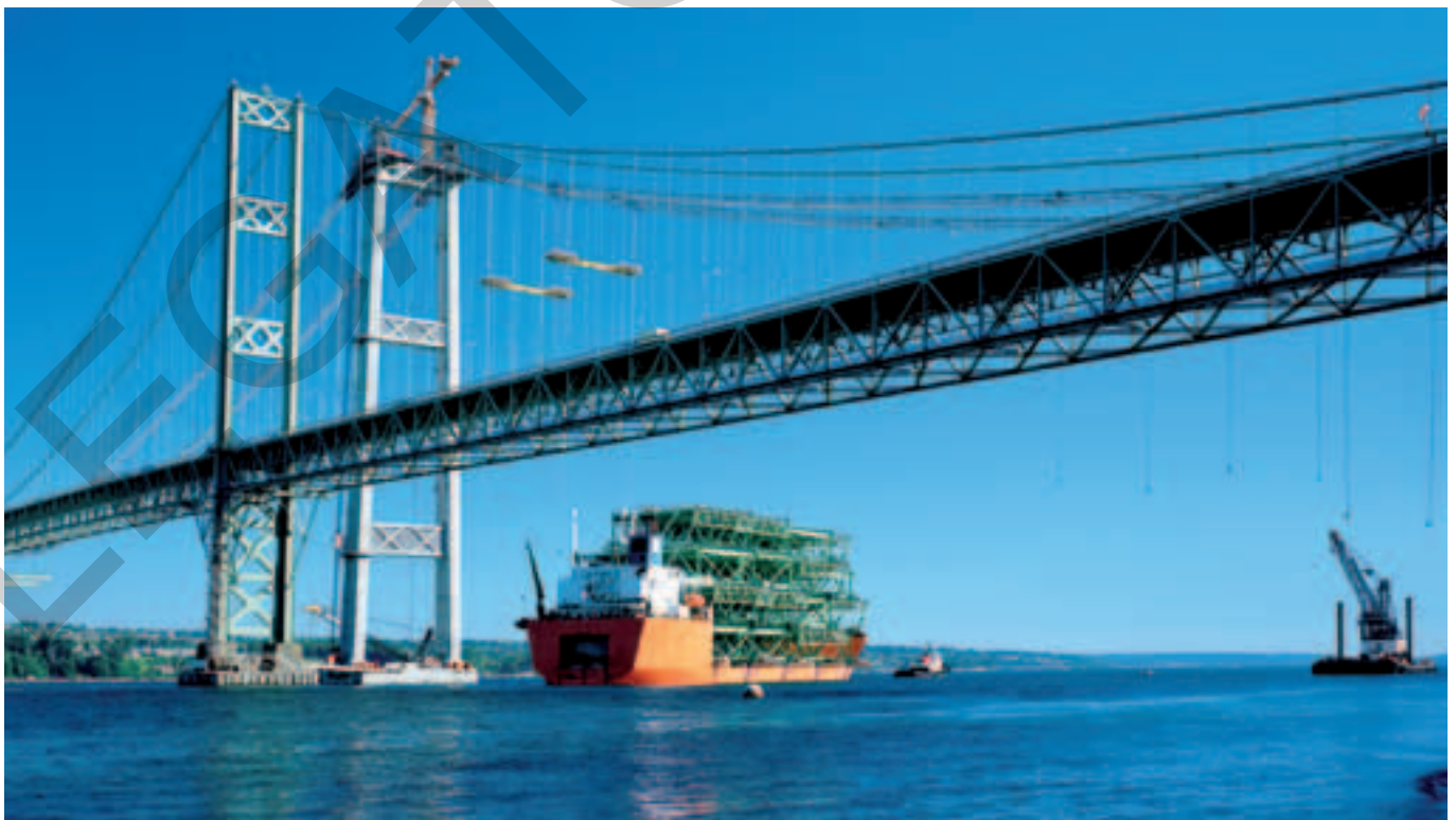
A Tacoma Narrows híd 1.645,92 m hosszával a világ 50 leghosszabb hidja közé tartozik. Az acélszerkezetét két párhuzamos építmény alkotja, amely összeköti a Kitsap-félszigetet a fővárossal, Bremerton-nal.
